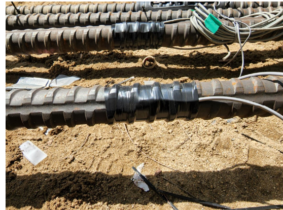
(d) 3rd waterproof coating (Vinyl electrical tape)
