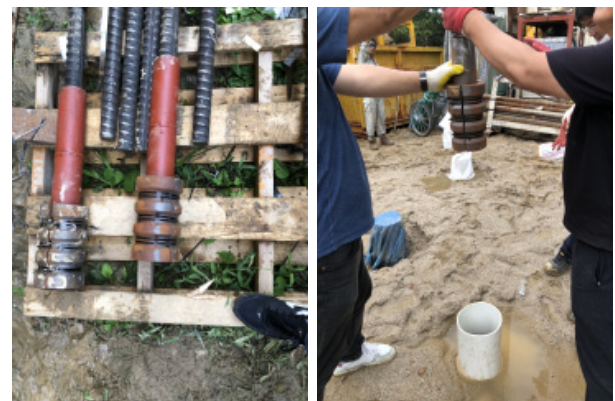
(c) Tip of base expansion micropile (d) Installation
